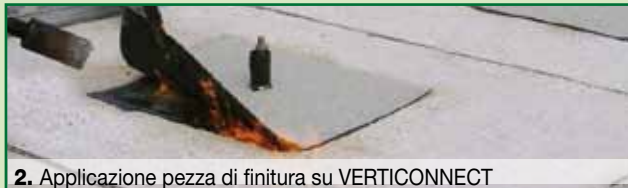
2. Applicazione pezza di finitura su VERTICONNECT
