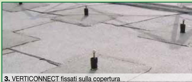
3. VERTICONNECT fissati sulla copertura
