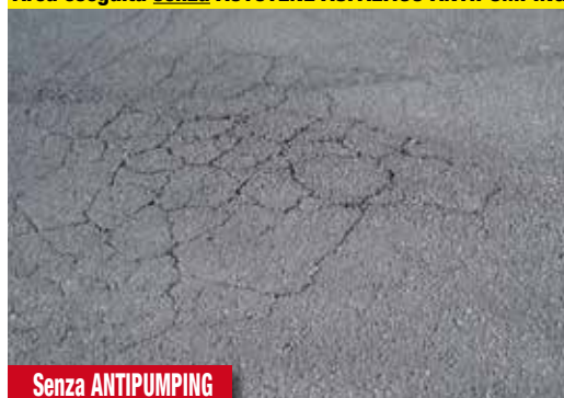
Area eseguita senza AUTOTENE ASFALTICO ANTIPUMPING
