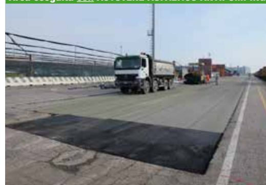
Area eseguita con AUTOTENE ASFALTICO ANTIPUMPING
