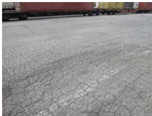
Area eseguita senza AUTOTENE ASFALTICO ANTIPUMPING
