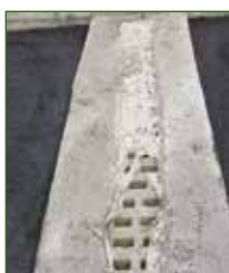
Il canale viene bloccato da un getto di cls
