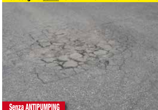
Area eseguita senza AUTOTENE ASFALTICO ANTIPUMPING
