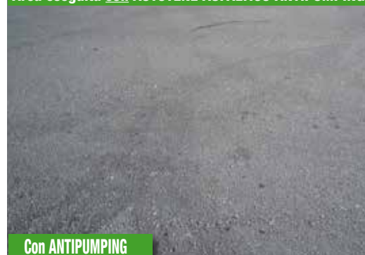
Area eseguita con AUTOTENE ASFALTICO ANTIPUMPING
