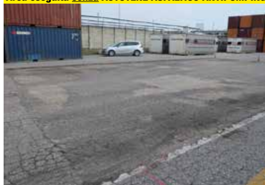
Area eseguita senza AUTOTENE ASFALTICO ANTIPUMPING
