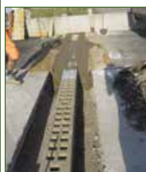
Il canale viene bloccato da un getto di cls
