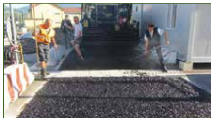
Stesura a caldo di un conglomerato aperto
