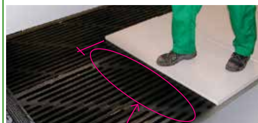
I pannelli di isolante adagiati sulla superficie appena sfiammata verranno fatti aderire al TECTENE BV STRIP EP mediante pressatura per semplice calpestio dell'operatore (da effettuarsi su tutta la superficie del pannello)
