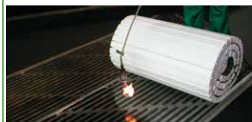
I rotoli di THERMOBASE srotolati sulla superficie appena sfiammata verranno fatti aderire al TECTENE BV STRIP EP mediante pressatura su tutta la superficie del rotolo mediante semplice calpestio dell'operatore (da effettuarsi su tutta la superficie del pannello o rotolo)
